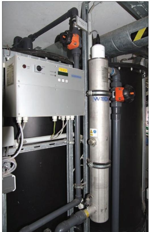
Abbildung 5: WEDECO-Bestrahlungskammer.
